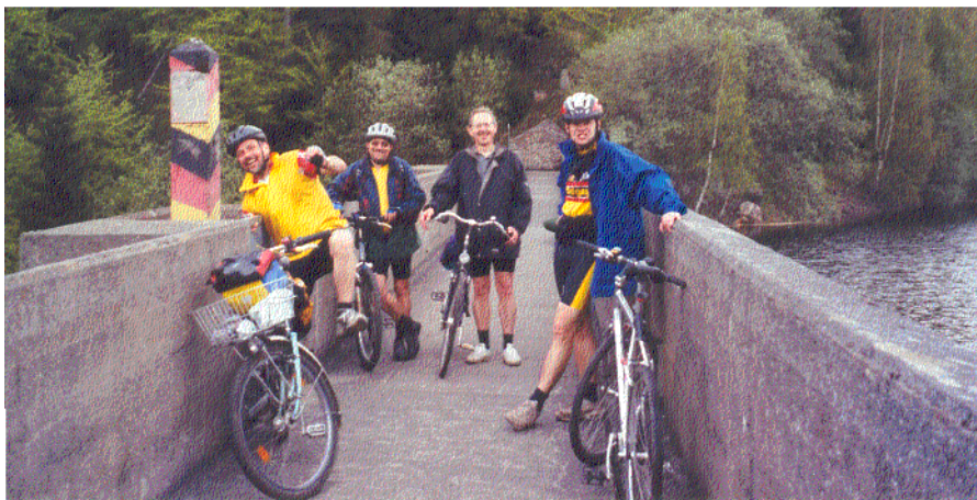
Staumauer an der Eckertalsperre
